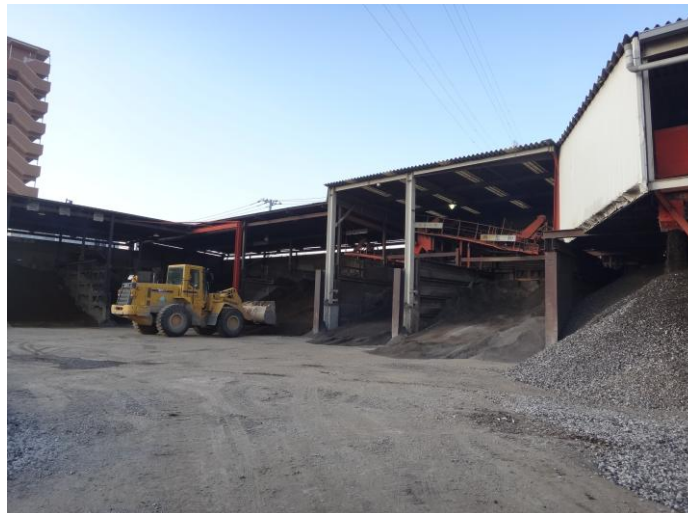
・製品ヤード全景
