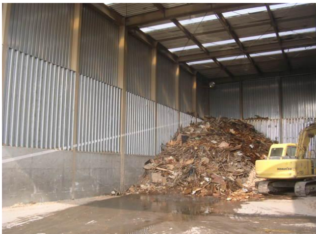
・廃材ヤード
