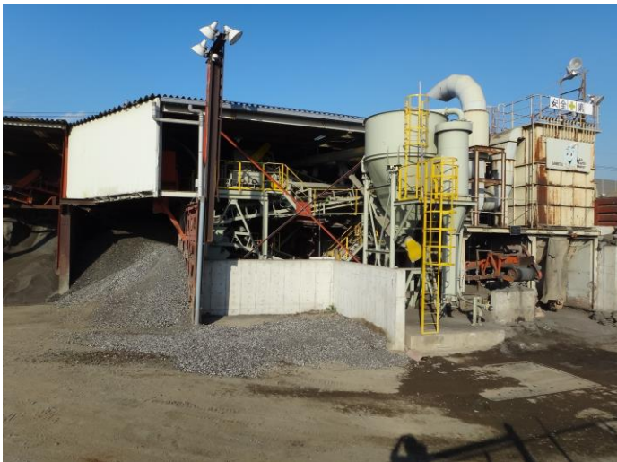
・リサイクルプラント全景
