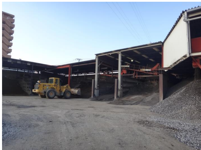
・製品ヤード全景
