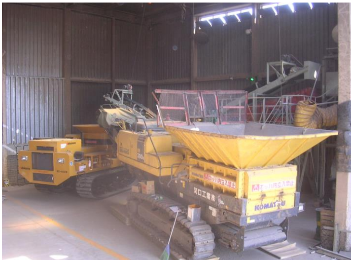
・木くず破碎施設
