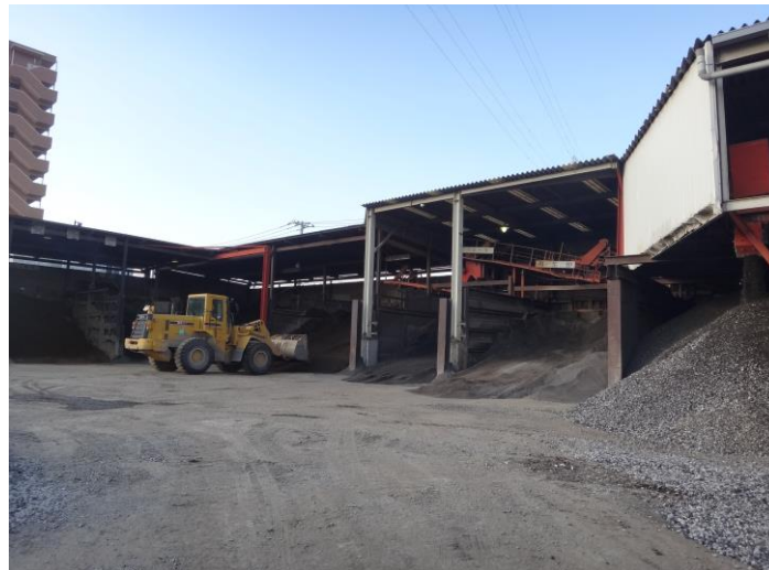
・製品ヤード全景
