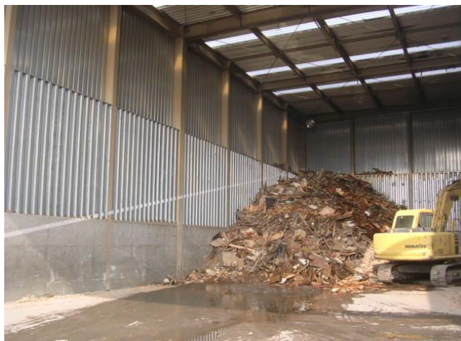
・廃材ヤード
