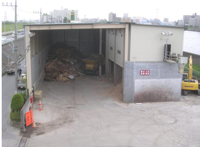
・木くず施設全景
