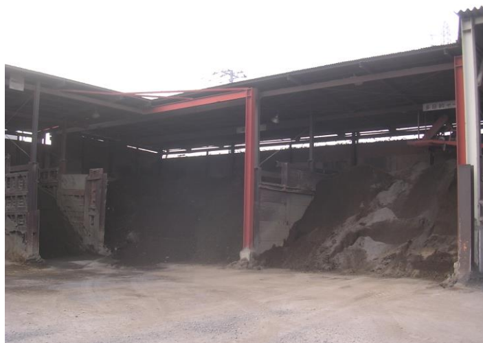
・改良土ヤード全景
