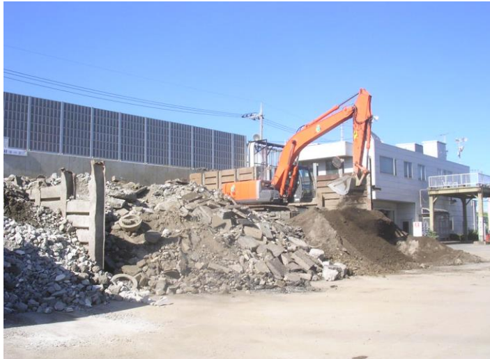
・残土ヤード全景
