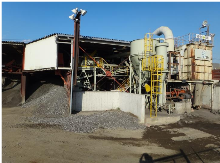
・リサイクルプラント全景
