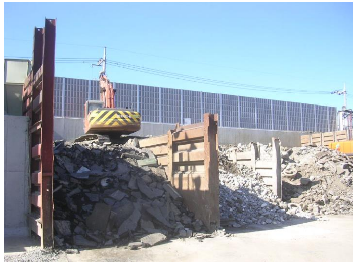
・廃棄物ヤード全景
